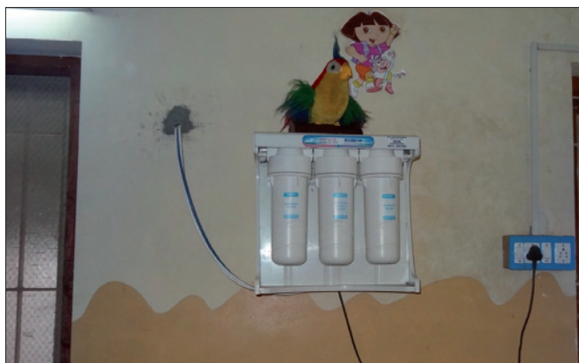
L'installation comprend 2 groupes de traitement (1 par étage)
